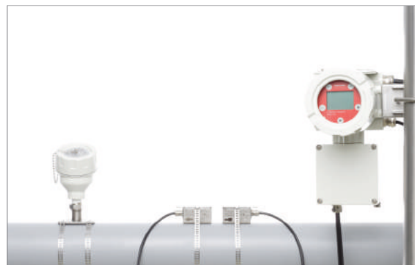
Montaż czujnika ATEX PT100 z KATflow 170 na rurociągu
