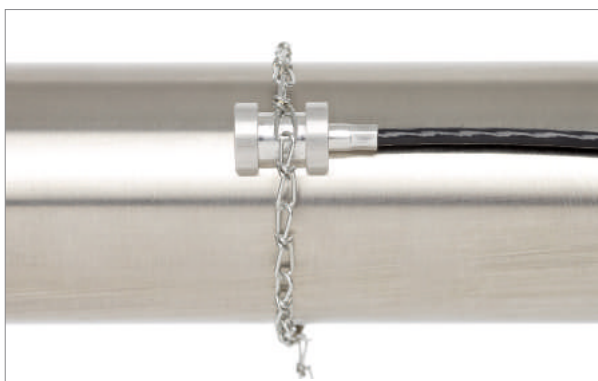
Czujnik PT100 przymocowany do rurociągu
